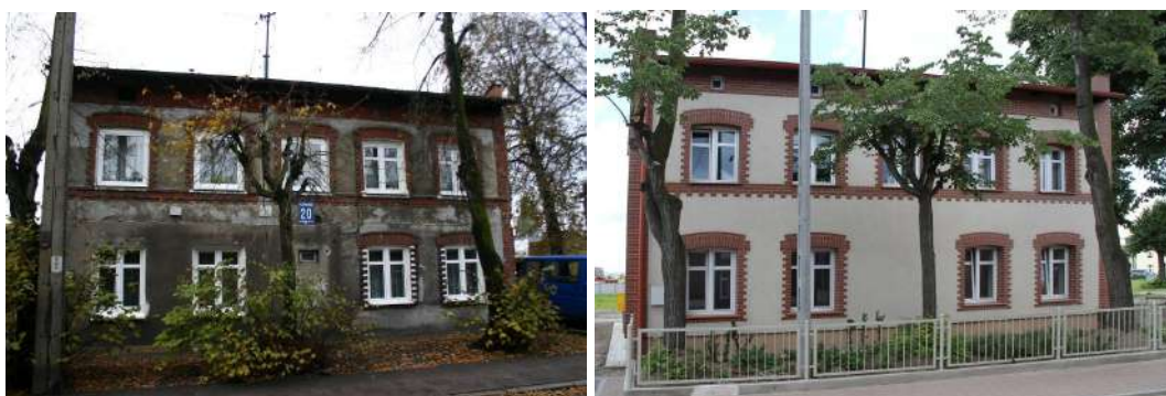
Rys. 5. Przykładowy budynek mieszkalny przy ulicy Starowiejskiej przed i po remoncie. Źródło: Oficjalny portal miasta Gdańska, Rewitalizacja Letnicy w Gdańsku , 2015, https://www.gdansk.pl/inwestycje-miejskie/Rewitalizacja-Letnicy-w-Gdansk,a,47055 (Dostęp: 01.05.2024)
