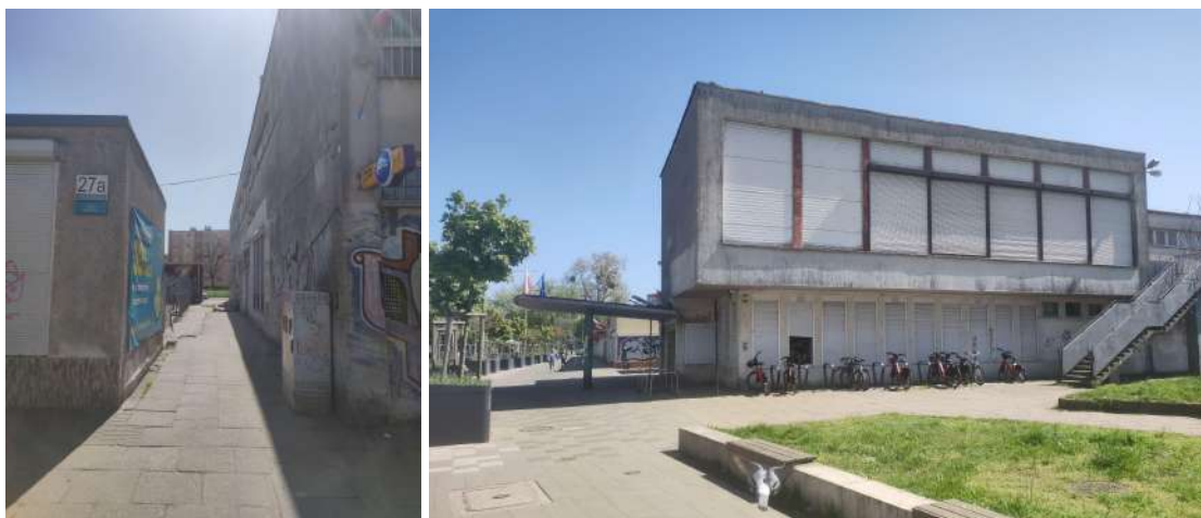
Rys. 21. Zdegradowanie budynków na przestrzeni Stogów. Źródło: zdjęcia własne.
