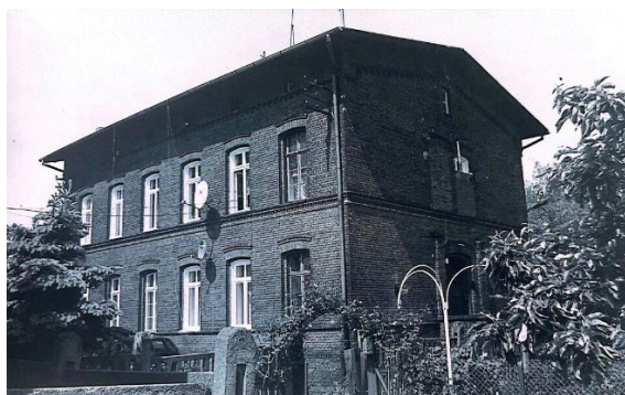
Rys. 31 zdjęcie z 2009 r. domu urzędników kolejowych
