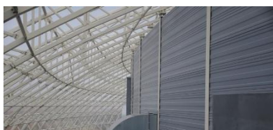
Rys. 77. Panele akustyczne na stadionie Arena Kraków, Źródło: https://akustyczne.pl/foto/obudowy-akustyczne-na-dachach-obiektow/arena-krakow (data dostępu 28.06.2024)
