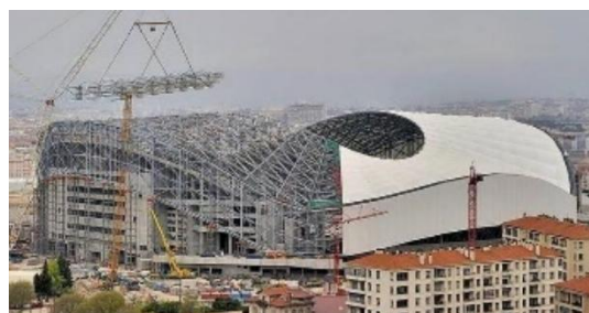
Rys. 54. Zdjęcie z budowy. Źródło: skyscrapercity.com/threads/marseille-stade-velodrome-67-394.401601/ (data dostępu: 07.06.2024)
