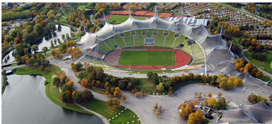
Rys. 29. Stadion Olimpijski w Monachium, Źródło: https://pl.wikipedia.org/wiki/Olympiastadion_München#/media/Plik:Olympiastadion_Muenchen.jpg (data dostępu: 01.06.2024)
