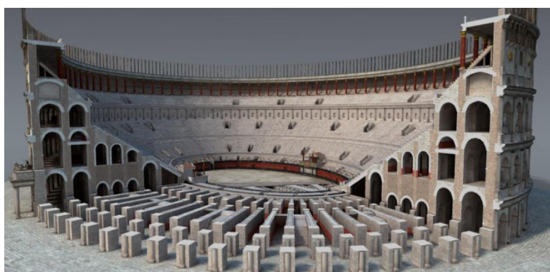
Rys. 20. Model 3d Koloseum z przekrojem przez widownię pokazującym zastosowaną konstrukcję. Źródło: https://www.mozaweb.com/pl/Extra-Modele_3D-Koloseum_Rzym_I_wiek_n_e-109427 (data dostępu: 01.06.2024)
