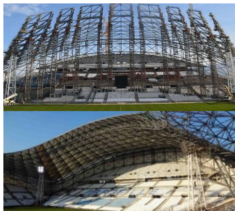
Rys. 48. Zdjęcia z budowy. Źródło: skyscrapercity.com/threads/marseille-stade-vélodrome-67-394.401601/ (data dostępu: 07.06.2024)
