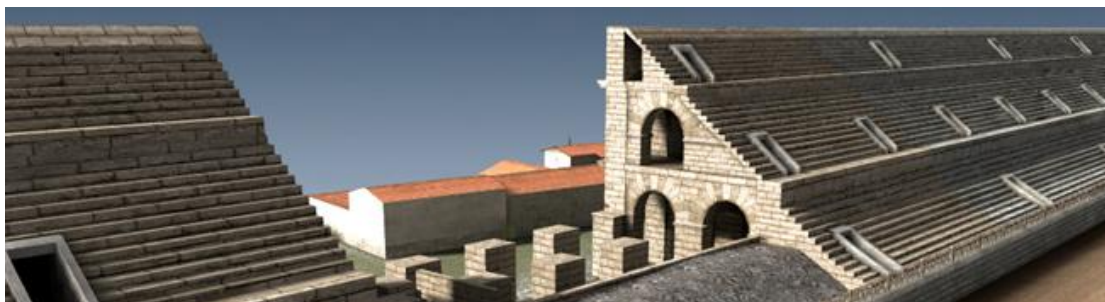
Rys. 16. Model 3d Circus Maximus z przekrojem przez widownię pokazującym zastosowaną konstrukcję. Źródło: https://www.mozaweb.com/pl/Extra-Modele_3D-Circus_Maximus_Rzym-148048 (data dostępu: 01.06.2024)
