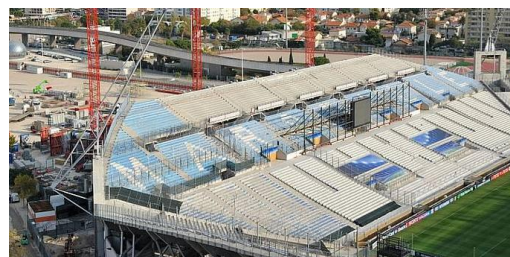
Rys. 44. Zdjęcie z budowy. Źródło: skyscracity.com/threads/marseille-stade-vélodrome-67-394.401601/394.401601/ (data dostępu: 07.06.2024)
