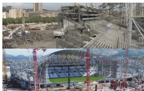
Rys. 50. Zdjęcia z budowy. Źródło: skyscrapercity.com/threads/marseille-stade-vélodrome-67-394.401601/ (data dostępu: 07.06.2024)
