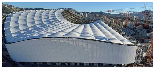
Rys. 52. Zdjęcie z budowy. Źródło: skyscrapercity.com/threads/marseille-stade-vélodrome-67-394.401601/ (data dostępu: 07.06.2024)
