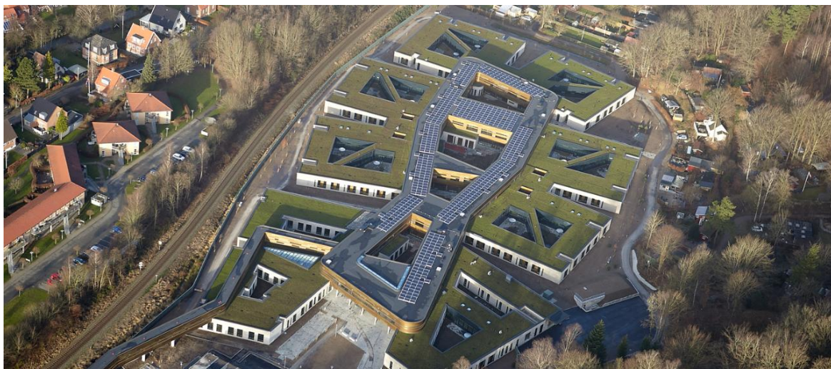
Rys. 10 Widok szpitala psychiatrycznego Vejle Psychiatric Hospital w Vejle w Danii (projekt Arkitema Architects) -wiele dziedzińców wewnętrznych zapewnia dużą ilość światła dziennego i dostęp do natury, https://www.archdaily.com/901732/vejle-psychiatric-hospital-arkitema-architects?ad_source=search&ad_medium=projects_tab
