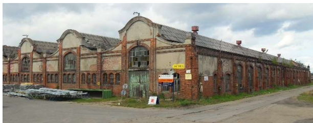
Rys. 48. Zakłady Naprawcze Taboru Kolejowego przed pożarem
