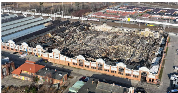
Rys. 49. Zakłady Naprawcze Taboru Kolejowego po pożarze
