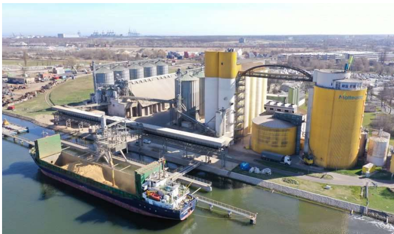
Rys. 53. Nabrzeże Bytomskie Portu Gdańsk na Przeróbce
