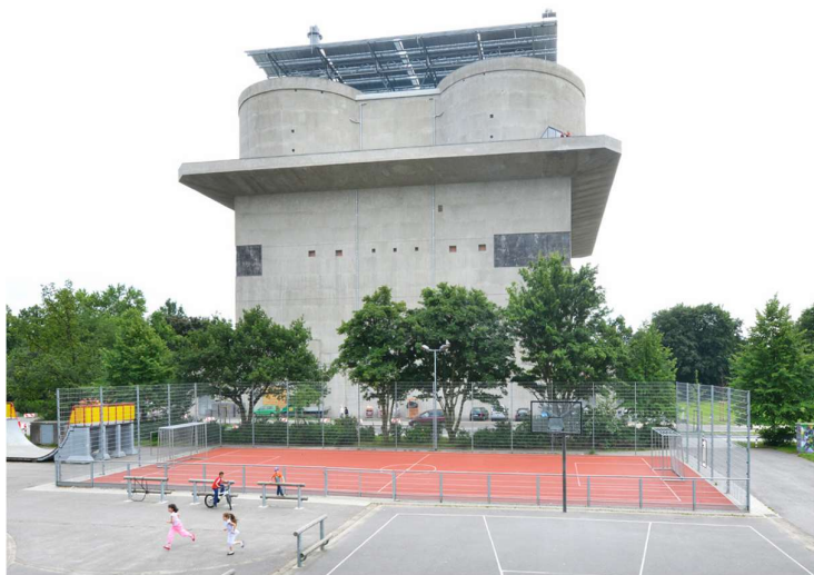
Rys. 7. Energy Bunker – schron z czasów II wojny światowej po transformacji, rok 2013 Źródło: 140801 Energy Bunker english final.pdf (20.07.2025 r.)
