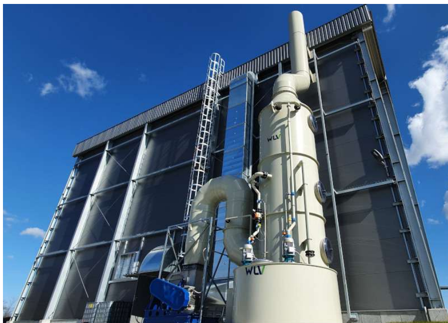
Rys. 5 budynek Baltic Fire Laboratory źródło: https://www.bafilab.com/galleries
