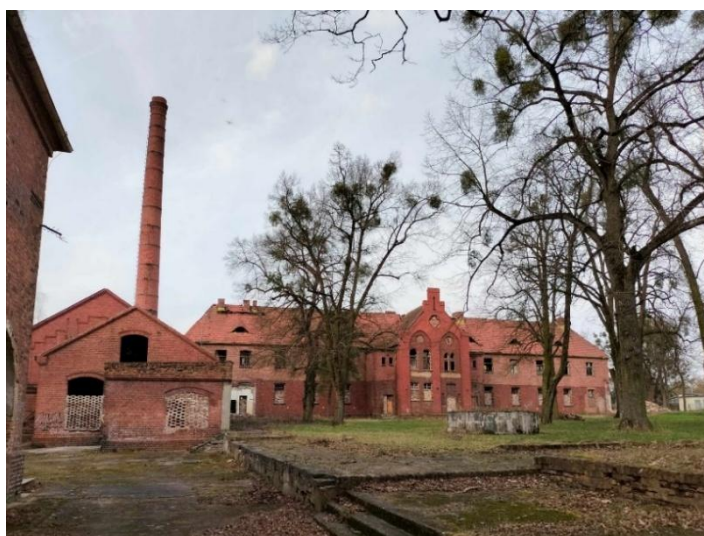
Ilustracja 25: Owińska, stan obecny nowego Zakładu – kotłownia i pawilon dla mężczyzn niespokojnych, wykonanie własne
