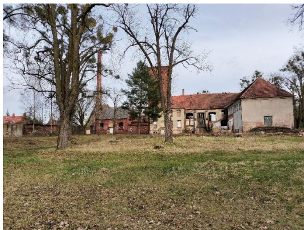
Ilustracja 28: Owińska, stan obecny nowego zakładu – blok gospodarczy, budynek administracji z wieżą ciśnień, wykonanie własne
