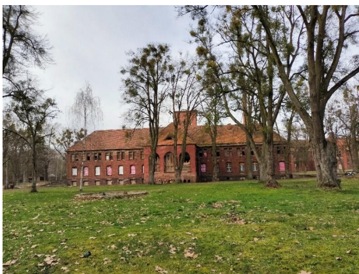
Ilustracja 26: Owińska, stan obecny nowego Zakładu – budynek administracji, wykonanie własne
