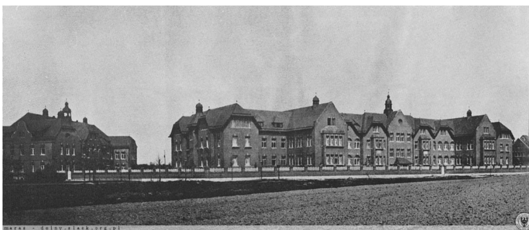
Ilustracja 9: Zdjęcie archiwalne Okręgowego Szpitala Kolejowego, wcześniejszego szpitala żydowskiego, źródło: https://polska-org.pl/508904,Wroclaw,Okregowy_Szpital_Kolejowy_dawny.html
