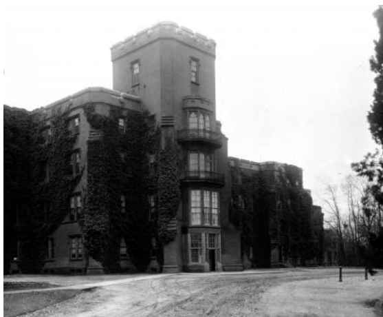
Ilustracja 5: Budynek centralny, zachodni kampus szpitala St. Elizabeths współcześnie, źródło: https://www.cfa.gov/about-cfa/design-topics/historic-preservation/center-building-st-elizabeths-hospital-west-campus
