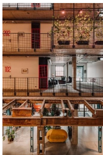
Zdjęcie 2. Ponownie wykorzystane rury, które znajdowały się od początku w Cukrowni Żnin.
