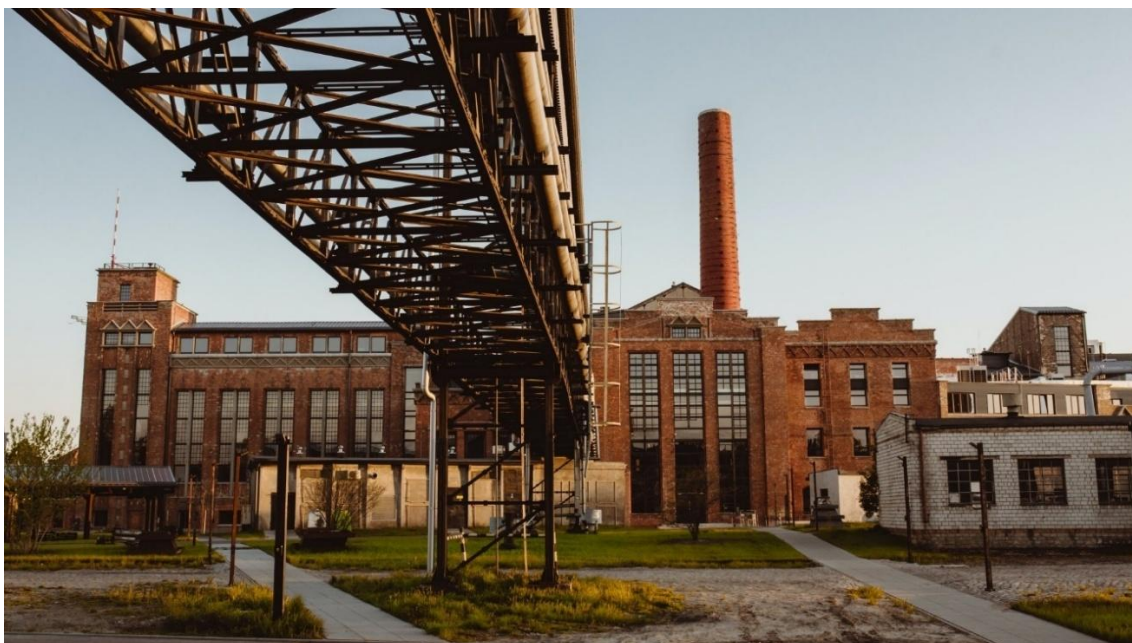
Zdjęcie 1. Cukrownia Żnin po przejściu kompleksowej rewitalizacji.
