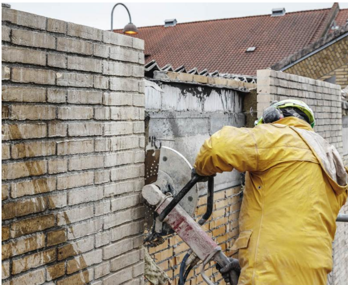
Zdjęcie 10. Proces pozyskiwania komponentów elewacyjnych dla projektu budynku Resource Rows w Kopenhadze.
