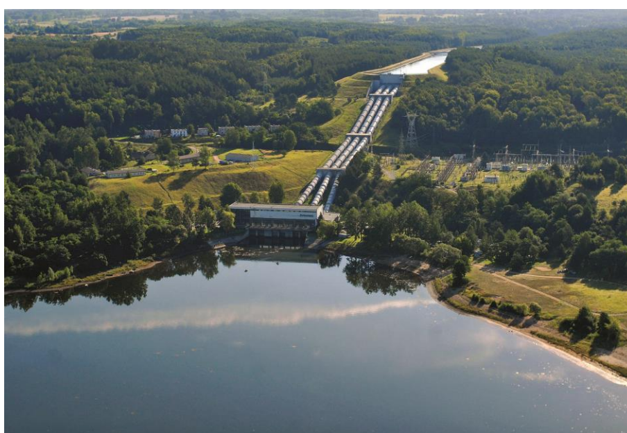
II.14 Widok na elektrownię łącząca dwa jeziora
