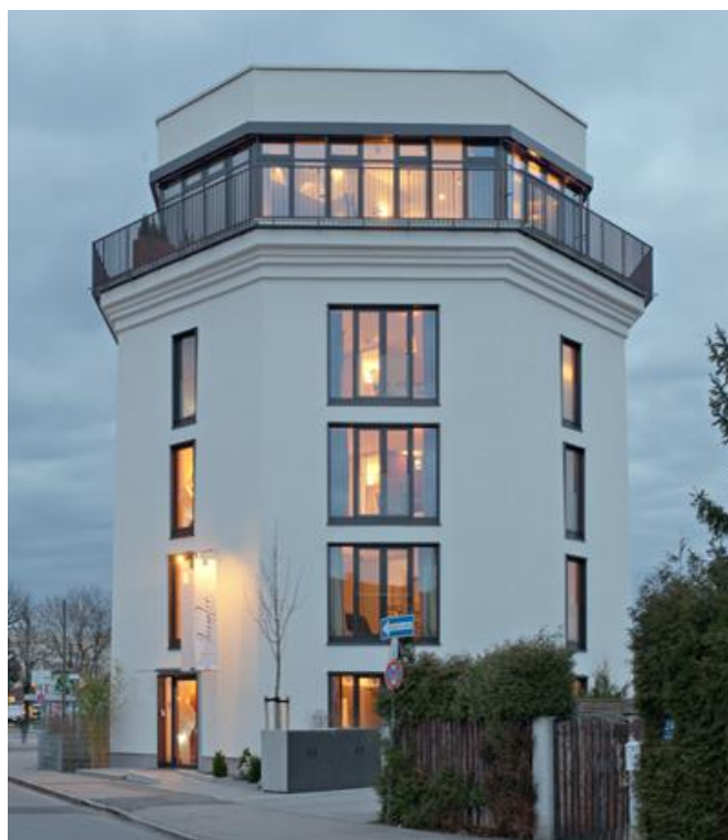
Il.29 Zdjęcie bunkra po przebudowie
