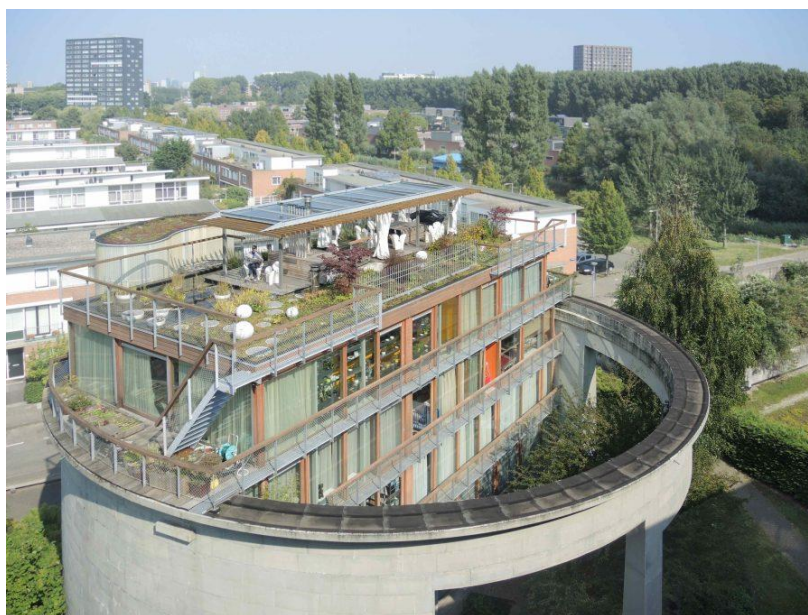
Il.20 Zdjęcie zbiornika po przebudowie
