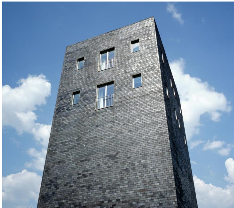
Il.25 Zdjęcie przebudowanego silosu
