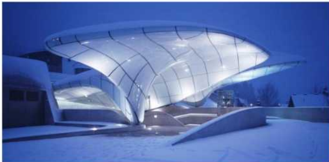
Rys. 3.14. Stacja kolejki linowej w Innsbrucku projektu Zahy Hadid.
