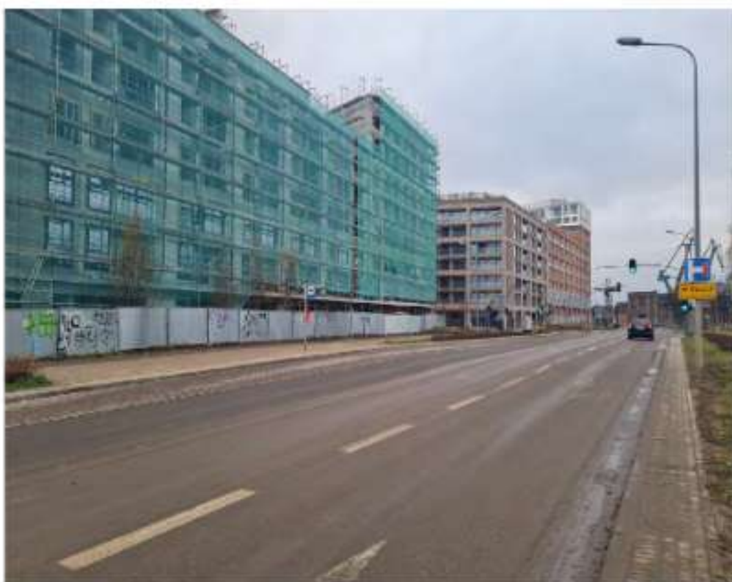
Fot. 7. Widok na ul. Nową Wałową, na drugim planie inwestycja Żurawie (źródło: zdjęcie własne)
