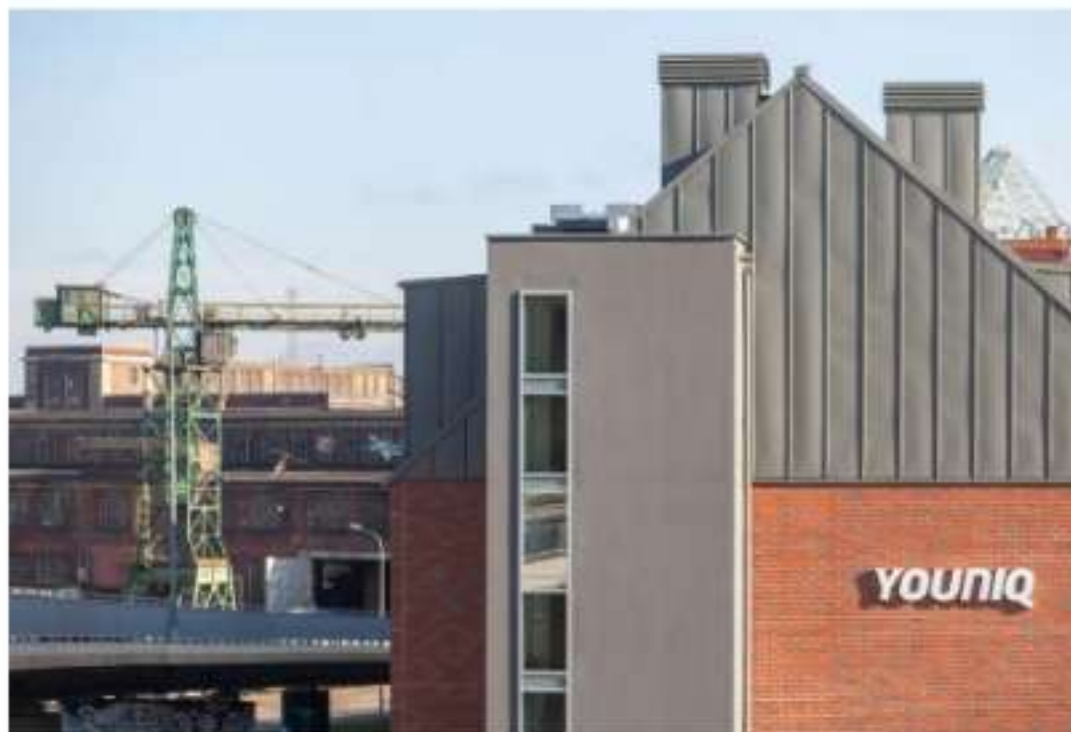
Fot. 13. Widok na boczną elewację budynku Youniq w Gdańsku (Źródło: https://www.housemarket.pl/inwestycje/102/upside_property_oddaje_pierwszy_w_polsce_koncept_apartamentow_na_wynajem_sieci_youniq.26083-40861.html#img )
