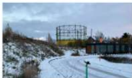
Fot. 2. Pozostałości dawnej Gazowni (źródło: zdjęcie własne)
