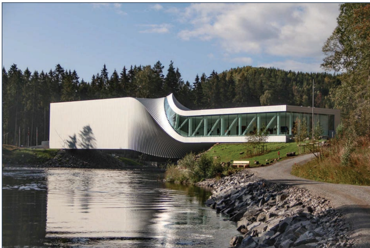
Rys.15 Galeria sztuki The Twist - widok od strony dojścia pieszego. 200
