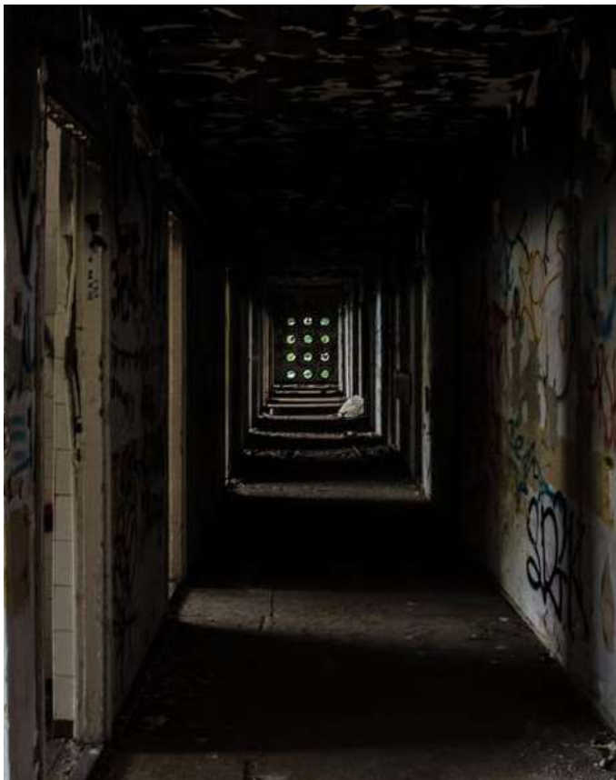
(il.5). Widok na perforacje z wnętrza budynku.
