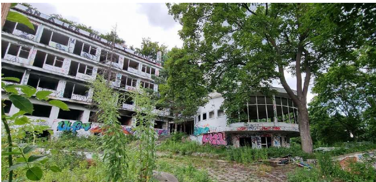
(il.8). Widok na budynek z dnia 16.07.2021.
