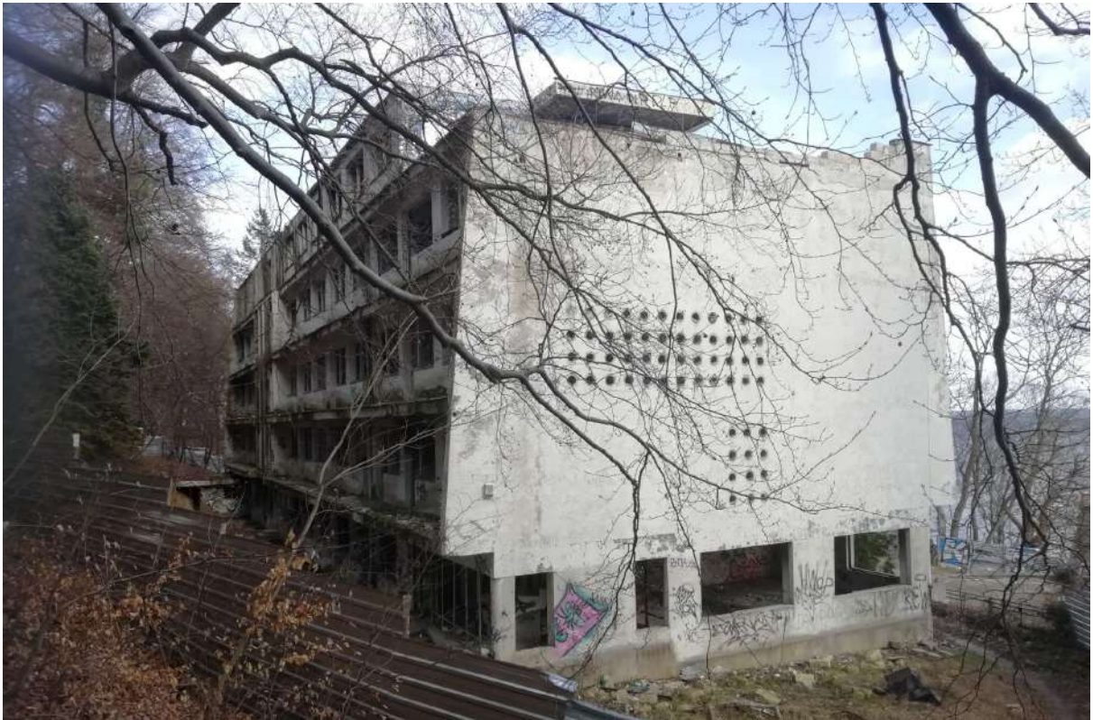
(il.4). Widok na perforacje w elewacji zachodniej budynku.
