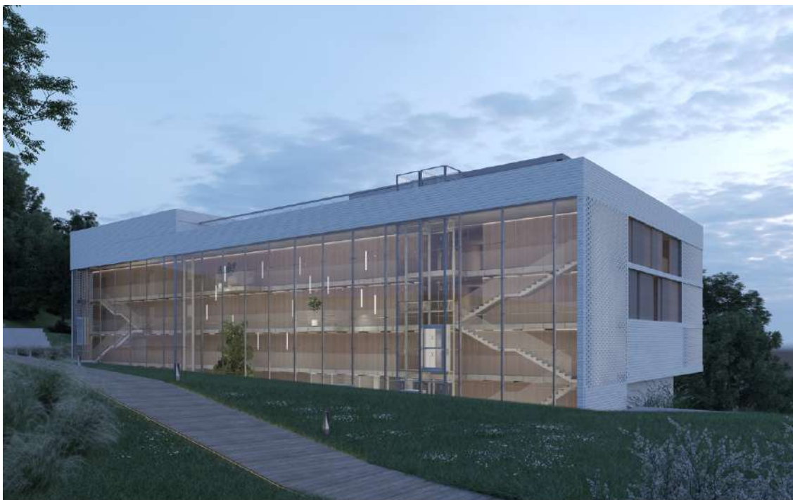
il.18. Widok na budynek od strony północno zachodniej.
