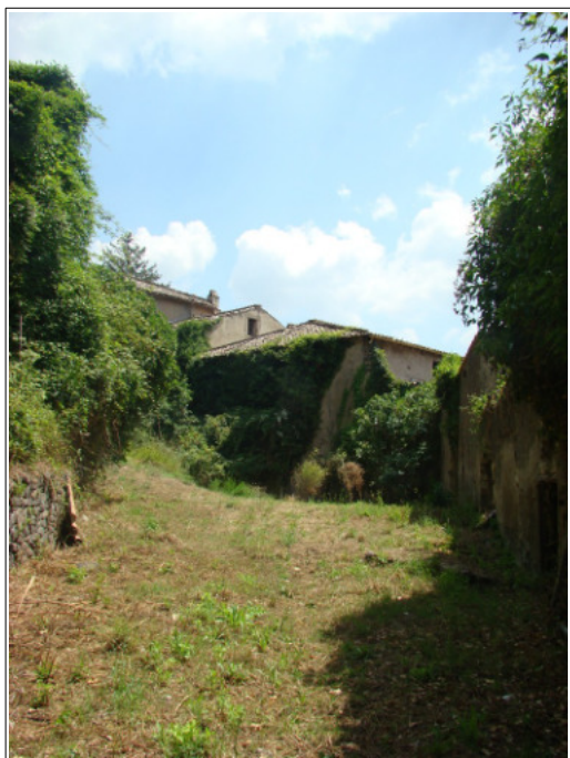
Rys. 1.14 Widok na północną elewację papierni. Źródło: Archiwum prywatne.
