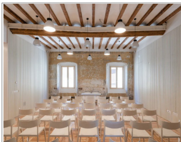
Rys. 3.6 Wnętrze centrum - aula. Widoczne przenikanie się oryginalnych i nowych elementów konstrukcyjnych i wykończeniowych w obiekcie. Opracowanie: Carles Crosas, SOG design. Źródło: portal archdaily.com
