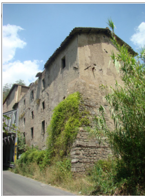
Rys. 1.20 Widok na przyporę od południowej strony cartiera di sopra, znajdującą się w miejscu dawnej wieży. Źródło: Archiwum prywatne.
