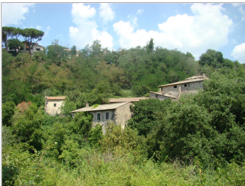
Rys. 1.21 Widok papiernię i dolinę z drogi Sant'Anna. Z przodu widoczny jedyny pozostały budynek cartiera di sotto. Źródło: Archiwum prywatne.
