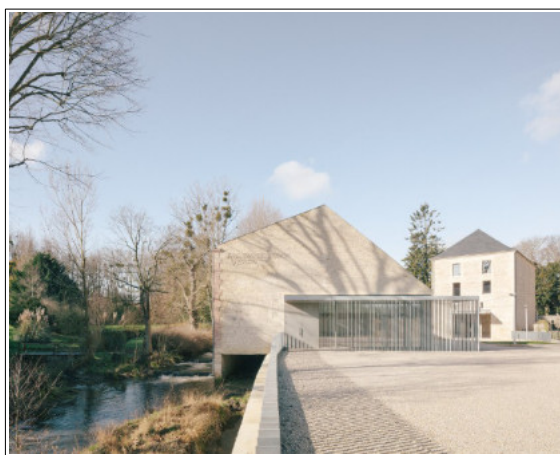
Rys. 3.8 Widok na elewację frontową i nowe wejście. Zdjęcie autorstwa Charly Broyez. Źródło: portal archdaily.com
