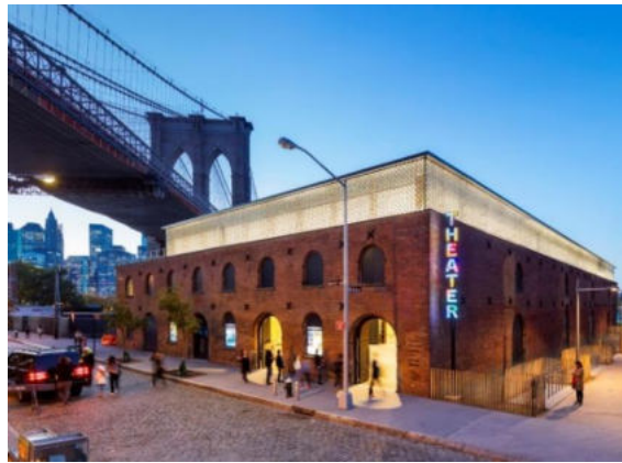
Rys.4.2.2.3. Widok magazynu po adaptacji
