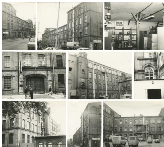
Rys. 6.1.4. Ujęcia historyczne Pończoszarni, źródło: Karta Ewidencji Zabytków Architektury i Budownictwa
