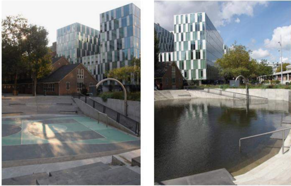
Rys. 3.3. Zbiornik retencyjny na skwerze wodnym Bethemplein Źródło: A. Bilka, Proces budowy miasta odpornego na przykładzie Rotterdamu
