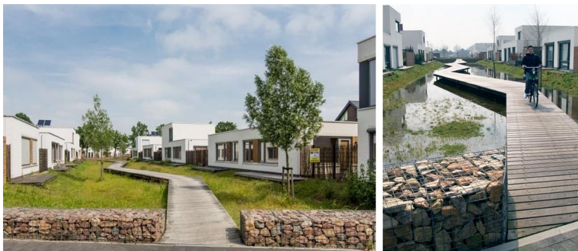
Rys.3.4. Water Sensitive Urban Design na osiedlu Piekenhoef w Holandii źródło: [1] eharchitecten.nl, [2] ocw.tudelft.nl [data dostępu: 22.04.2021r.]
