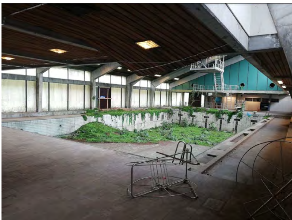
Fig. 32 Widok wnętrza basenu
