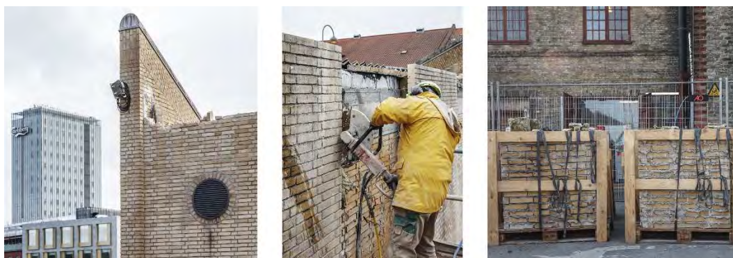
Fig. 7,8,9 Demontaż fragmentów fasady istniejącego budynku
