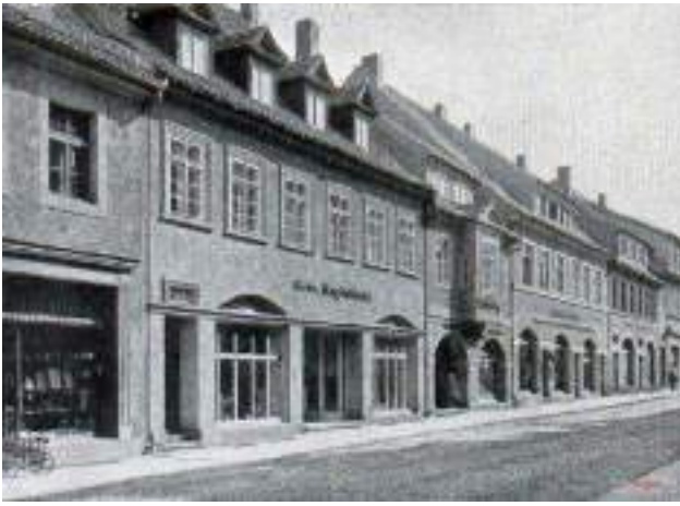
Rys. 26 Kamienice przy ul. Warszawskiej, 1920 rok
