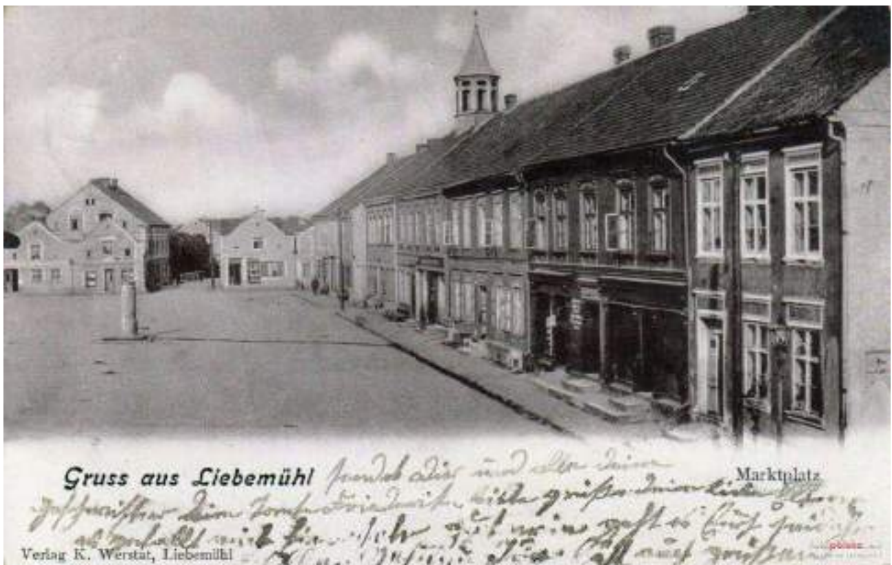
Rys. 49 Rynek w Miłomłynie, widok na południową pierzeję w kierunku wschodnim
