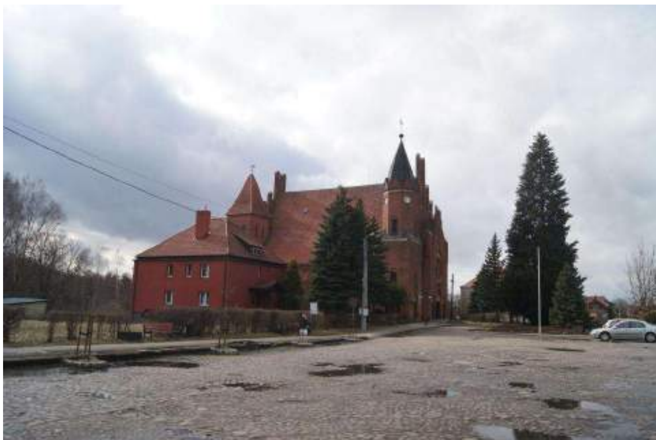
Rys. 35 Widok na kościół, południową i zachodnią pierzeję dawnego rynku
