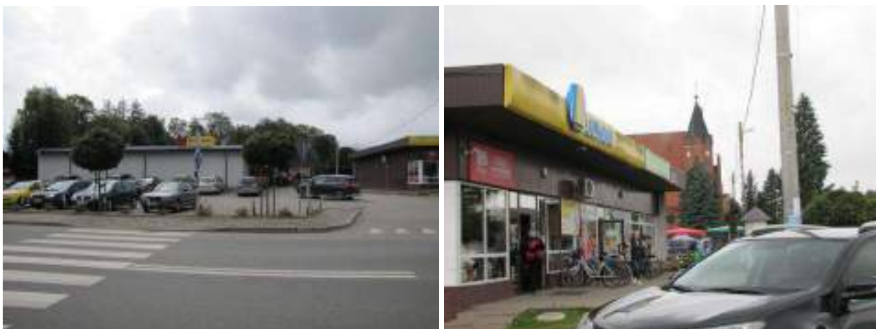
Rys. 30/31 Budynki handlowo-usługowe dysharmonizujące z otoczeniem
