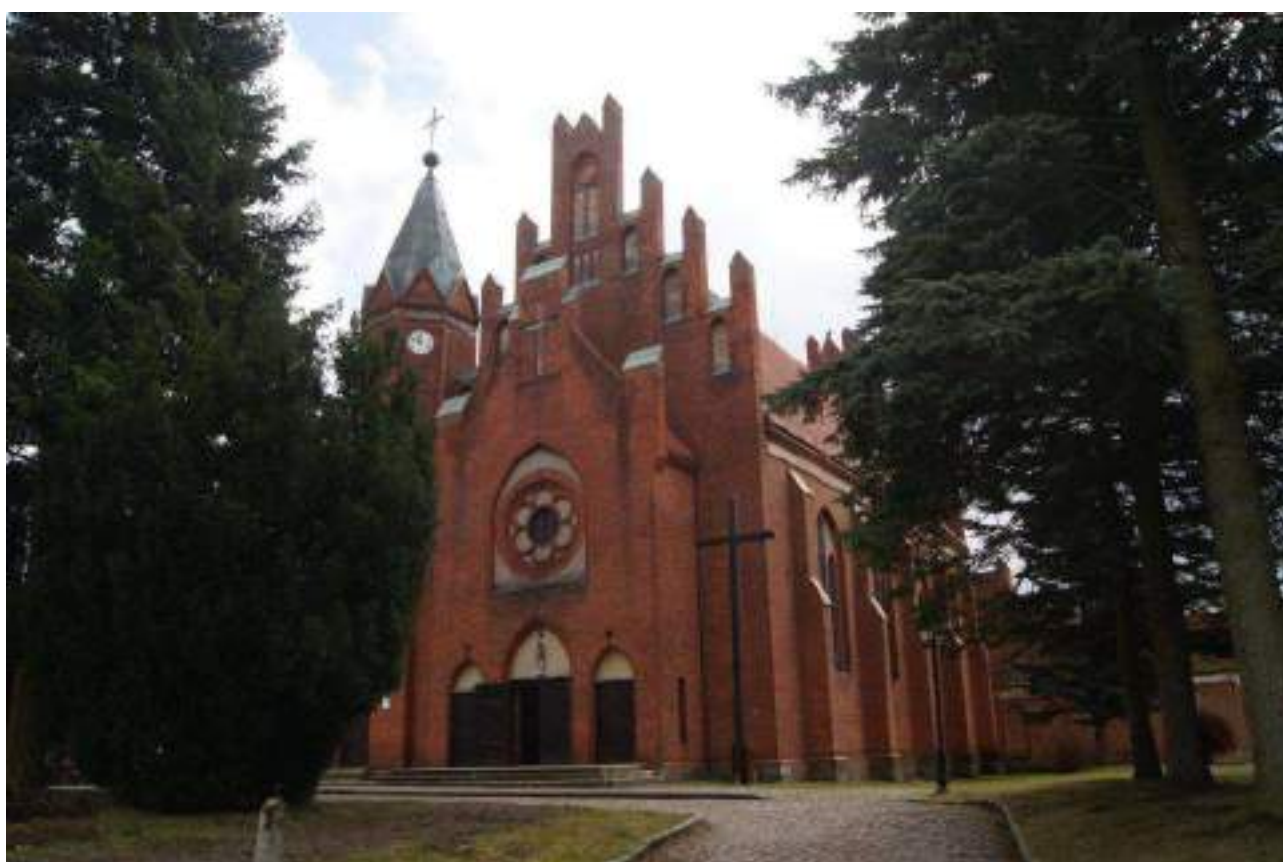
Rys. 36 Widok na kościół św. Bartłomieja
