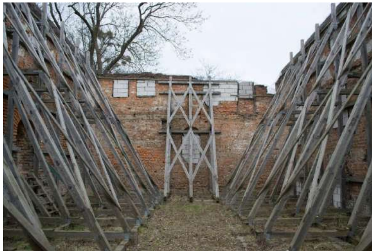
Rys. 89. Zdjęcie wnętrza młyna z tymczasową drewnianą konstrukcją wzmacniającą. [zdjęcie własne]
