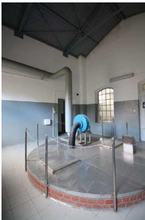
Rys. 85. Zdjęcie z pomieszczenia ze studnią umieszczonego w lewym skrzydle od hali pomp [Rochman Drohomirecki Architekci]
