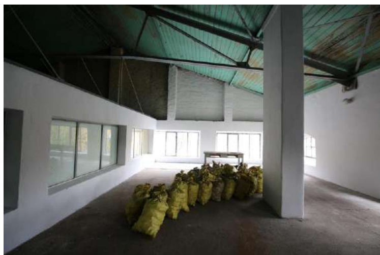
Rys. 86. Zdjęcie antresoli w hali pomp [Rochman Drohomirecki Architekci]
