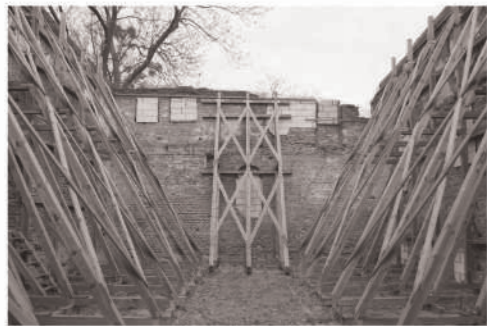
Młyn w 2021 roku - ściany wspomaganą są przez drewniane rusztowanie, a otwory okienne wypełnione zostały gabrielonem, źródło: fotografia własna
