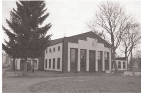
Widok od strony ulicy Kamienna Grodzka w 2021 roku. Źródło: fotografia własna
