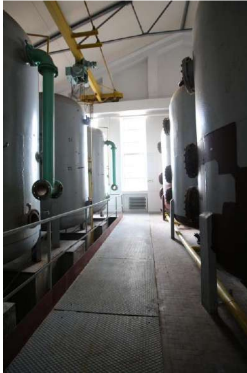
Rys. 87. Zdjęcie z hali odżelaziaczy zlokalizowanej w południowej części budynku [Rochman Drohomirecki Architektci]
