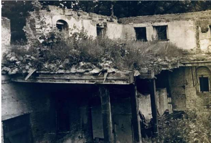
Rys. 54. Wnętrze młyna. Narożnik płn.-zach. z fragmentem zachowanych belek stropowych [Narodowy Instytut Dziedzictwa - oddział terenowy w Gdańsku]
