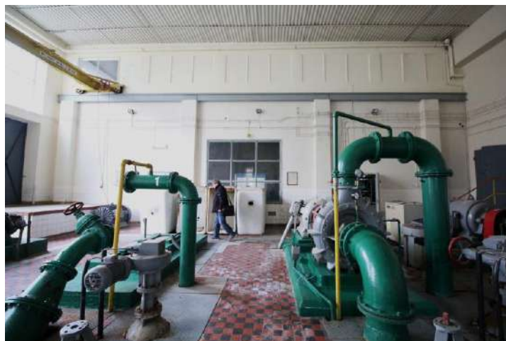
Rys. 84. Hala pomp znajdująca się w północnej części pompowni. [Rochman Drohomirecki Architekci]
