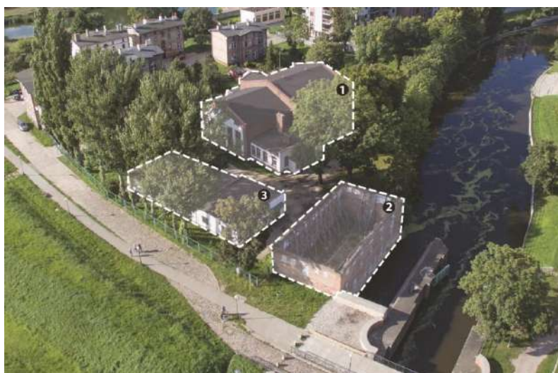
Rys. 82. Zdjęcie zespołu z drona. Budynek nr 1 – pompownia, budynek nr 2 - młyn, budynek nr 3 – budynek wspomagający pompownię. [opracowanie własne, zdjęcia autorstwa: Rochman Drohomirecki Architektki]
