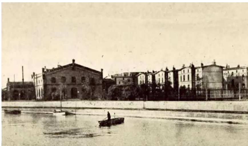
Rys. 62. Dolnomiejskie ujęcie wody i z prawej strony osiedle robotnicze przy ul. Grodza Kamienna, stan na lata 1905-1908 [Danzig und seine Bauten]
