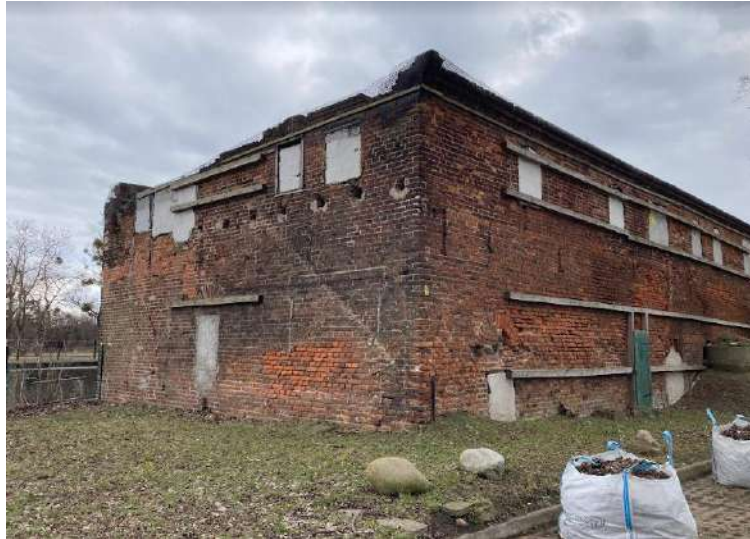
Rys. 88. Zdjęcie północnej elewacji młyna [zdjęcie własne]
