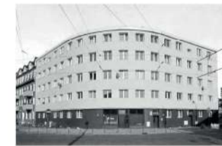
ZABUDOWA KOMUNALNA WMG Borykające się z przedłużeniem i złymi warunkami socjalnymi WMG rozbudowywało mieszkania komunalne. Zabudowa ta wyznacza dwa placce Nowego Portu: Wolności i ks.Gustowicza.
