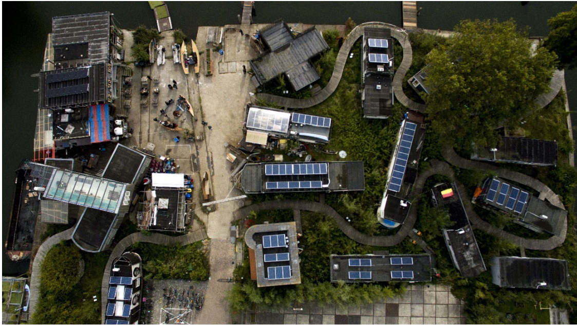
Rys. 13 Widok z góry na De Ceuvel (źródło: https://www.linkedin.com/company/de-ceuvel/ , data dostępu: 10.09.2022).
