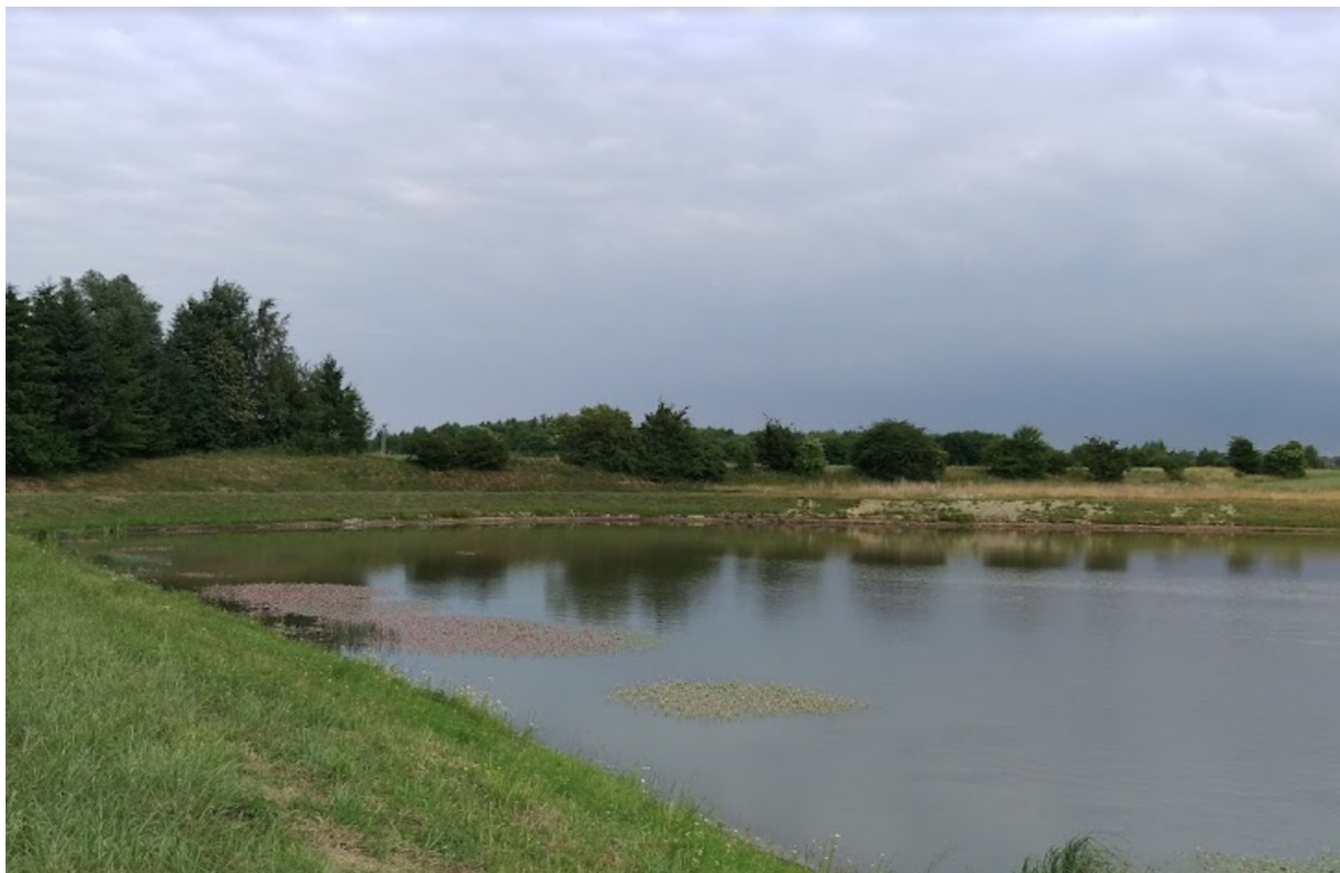
Rys. 18. Zbiornik retencyjny Rębiechowo III
