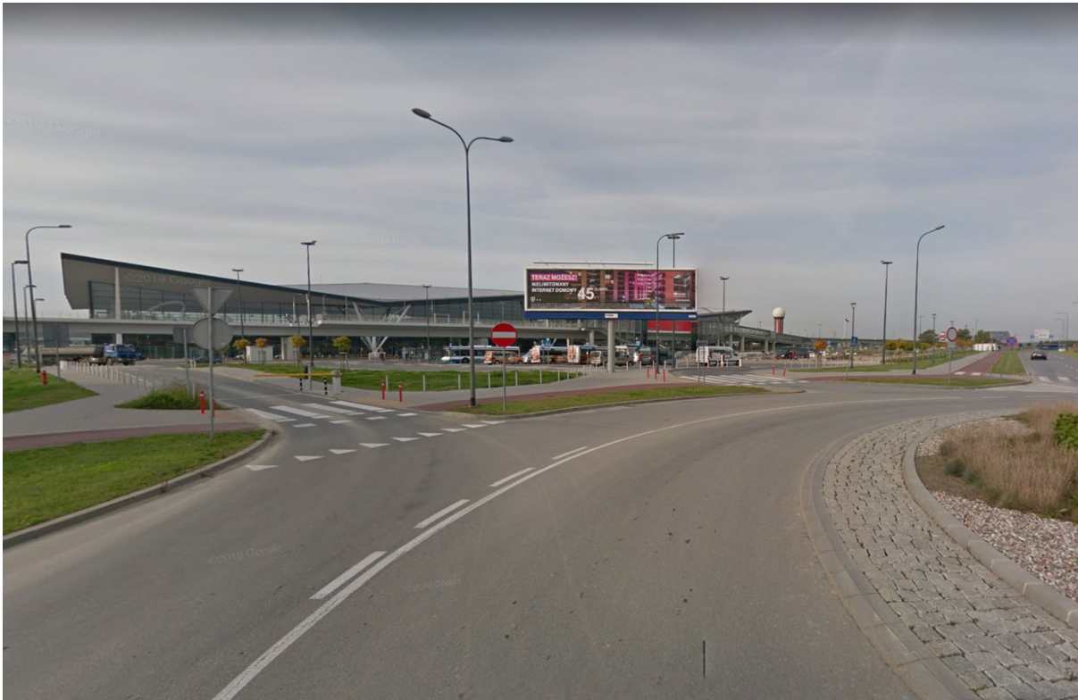
Rys. 13. Rondo przy ul. Juliusza Słowackiego; w oddali Terminal 2
