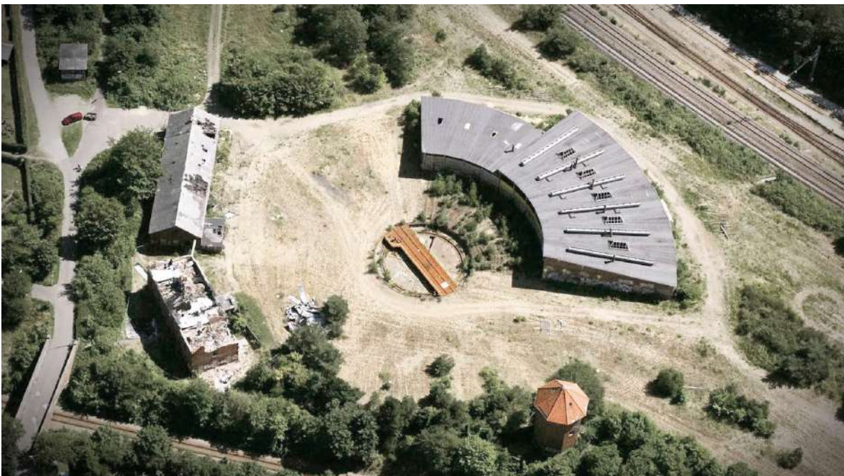
Ryc. 4. Widok z lotu ptaka na zespół budynków zajezdni przed interwencją.
