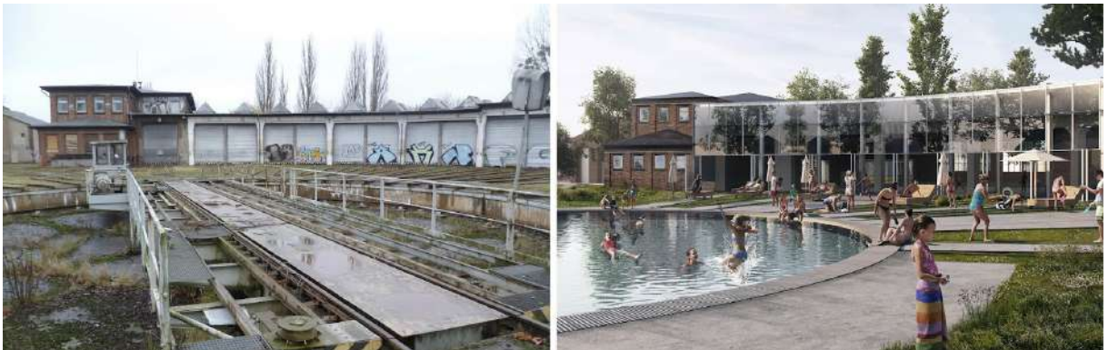
Ryc. 2. Budynek Lokschuppen 2. Po lewej zdjęcie stanu przed adaptacją, po prawej wizualizacja wprowadzonych zmian.
