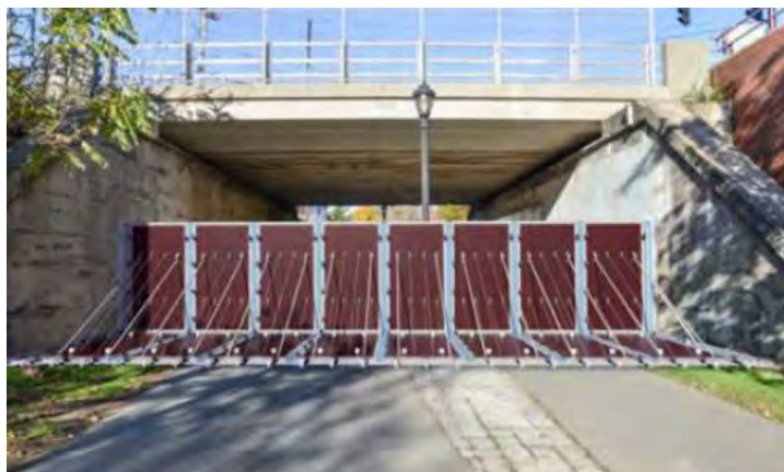
Rys. 6.24. Przykładowy wygląd ściany przeciwpowodziowej na East Boston Greenway pod Summer Street Źródło: https://www.boston.gov/departments/environment/climate-ready-east-boston-phase-i
