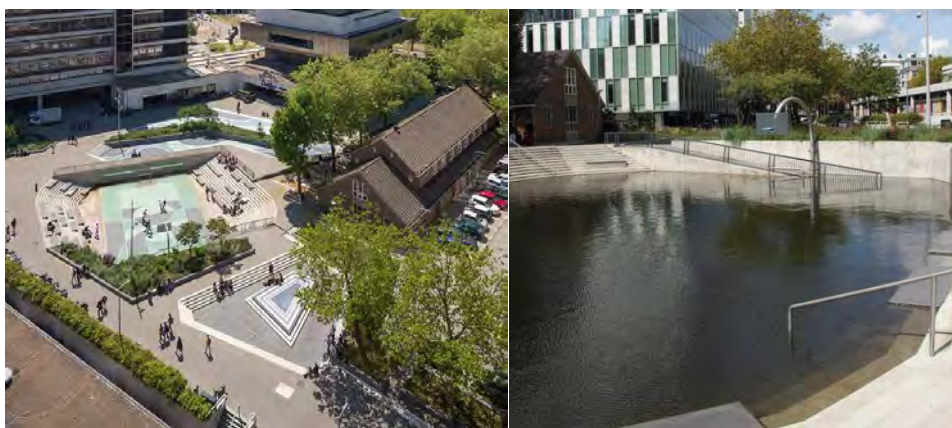
Rys. 6.12. Plac wodny Bethemplein w Rotterdamie
