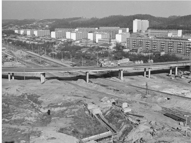
Rys. 3.11 Budowa Estakady Kwiatkowskiego. Źródło: https://historia.trojmiasto.pl/Przez-34-lata-w-budowie-Przypominamy-historie-trasy-Kwiatkowskiego-n167759.html
