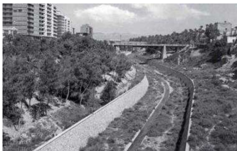
Ryc. 4.18. Niezagospodarowany dawny obszar, na którym powstał park The Braided Valley Źródło: https://www.publicspace.org/works/-/project/h190-the-braided-valley (dostęp z dn. 26.09.2022 r.)
