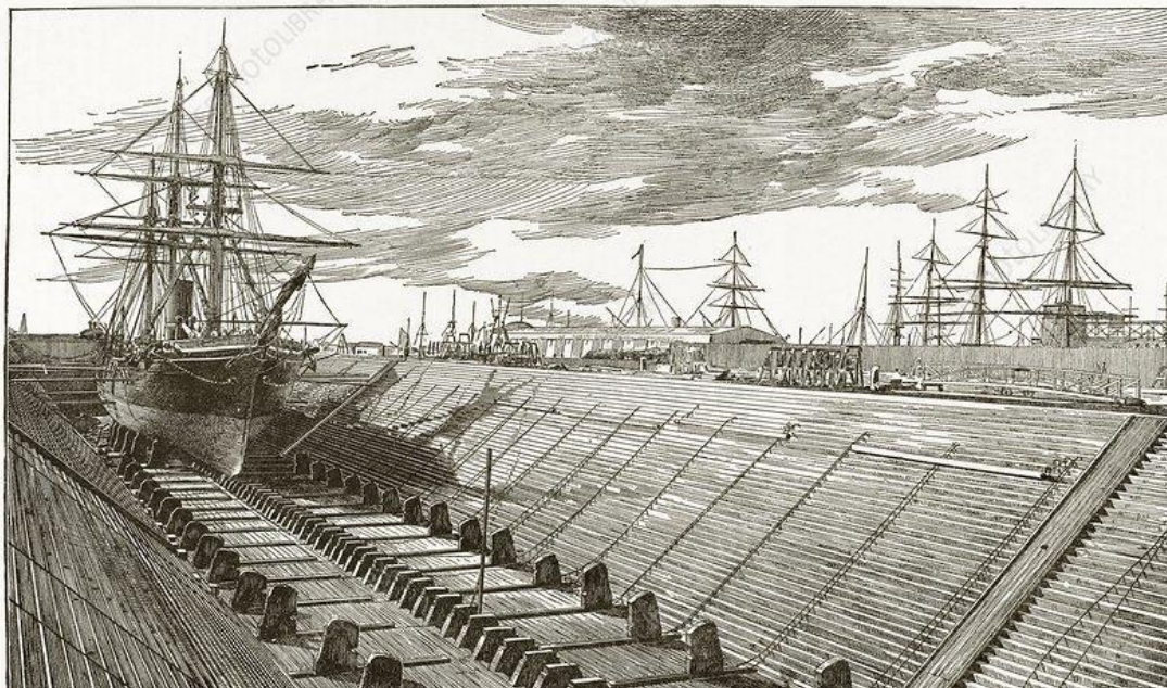
Rys. 6 (konstrukcja suchego doku)
