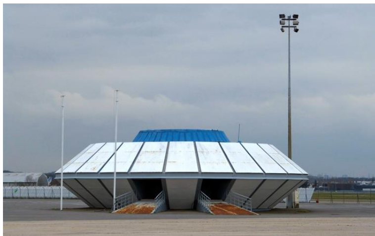
Il. 1.24. Pawilon Izraelski – jedyny budynek zainstalowany na stałe na pasach startowych, na północ od hali Granet. Źródło: H. Caroux, Le Hall d'exposition de l'aéroport du Bourget, Museum International , In Situ Revue des patrimoines, 2018, nr 35, str. 1-17.
