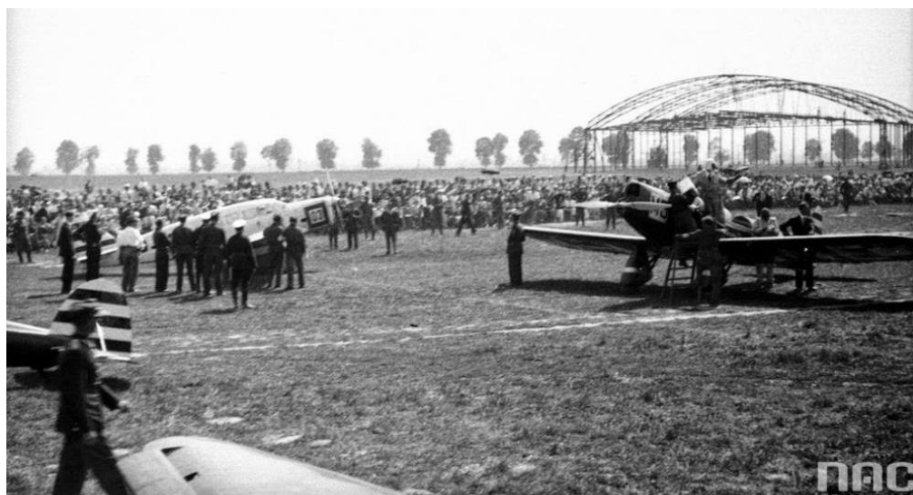
Il. 1.43. Port Lotniczy Kraków-Rakowice, Zawody Challenge 1932 r. W tle widać budowę hangaru. Źródło: https://fotopolska.eu/Krakow/b97269,Lotnisko_Rakowice-Czyzyny.html?f=1007173-foto [dostęp: 02.10.2021].
