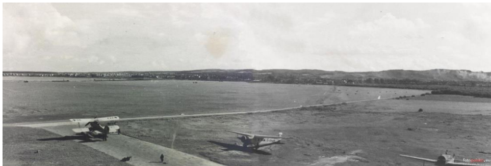
Il. 1.67. Lotnisko Szczecin-Dąbie od strony hangarów, 1938 r. Źródło: https://szczecin.fotopolska.eu/Szczecin/b64713,Lotnisko_Szczecin_-_Dabie.html?f=897007-foto [dostęp: 25.03.2020].
