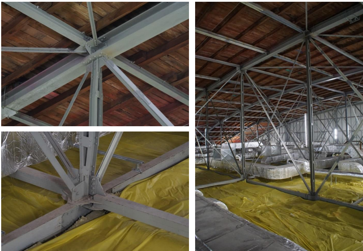
Il. 3.07. Nitowana konstrukcja stalowa w dawnym hangarze lotowskim. Zdjęcia z remontu prowadzonego w 2016 r. Fot. J. Szczepański.
