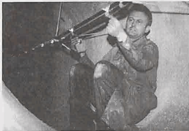
Mgr inż. Jan Szukalski montuje anodę ochrony katodowej w rurociągu wielkośrednicowym wody chłodzącej elektrowni w Łaziskach
