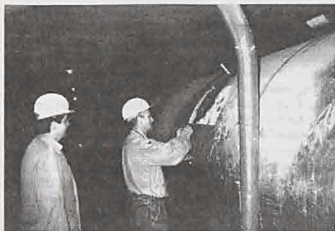
Mgr inż. Jan Szukalski ocenia stopień skorodowania rurociągu wielkośrednicowego wody chłodzącej elektrowni w Łaziskach
