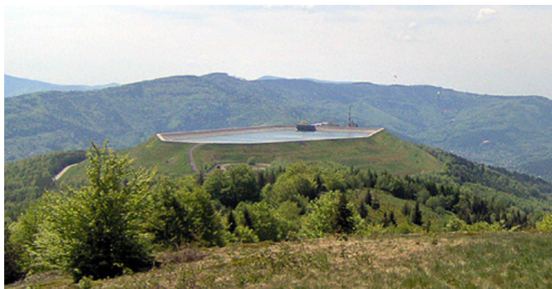
Fot: Elektrownia Szczytowo-pompowa Porąbka-Żar
