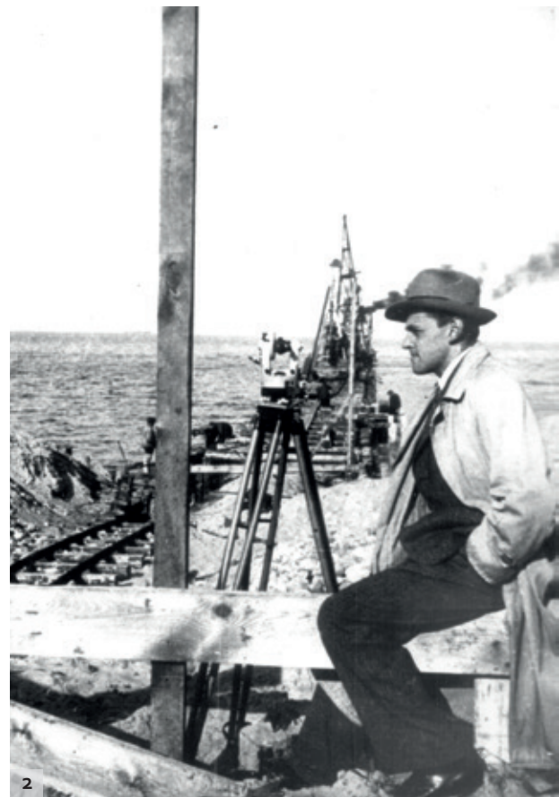
Fot. 2. Młody inżynier Stanisław Hueckel na budowie mola zachodniego w Wielkiej Wsi (od 1938 r. Władysławowo)
