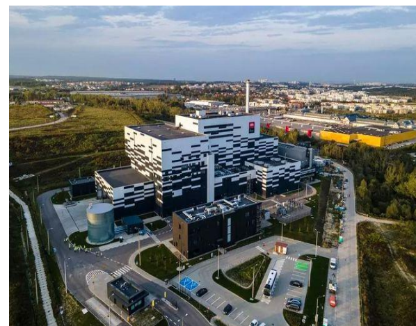
Spalarnia odpadów komunalnych 'Szadółki'
