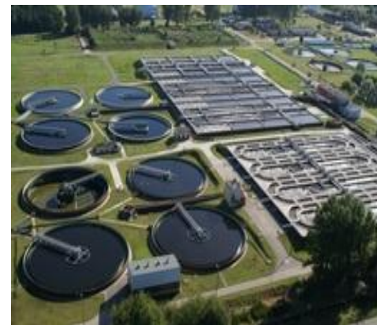
Oczyszczalnia ścieków "Dębogórze"
